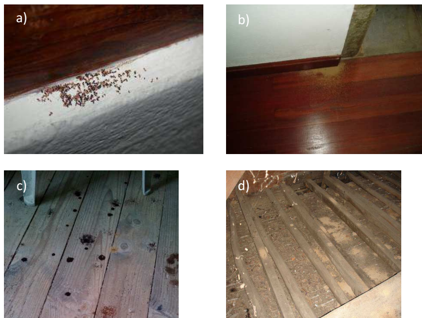
Figura 2: a) Exemplo de uma estrutura pouco infestada. Apenas se vê um indício pequeno de infestação. b) Exemplo de uma infestação moderada. Vêem-se alguns indícios, mas as madeiras estão intactas. c) Exemplo de uma infestação elevada onde já se encontram bastantes indícios e há necessidade de substituição de algumas madeiras. d) Exemplo de uma infestação muito elevada, onde os indícios são maiores e há necessidade de substituição de muitas madeiras.
